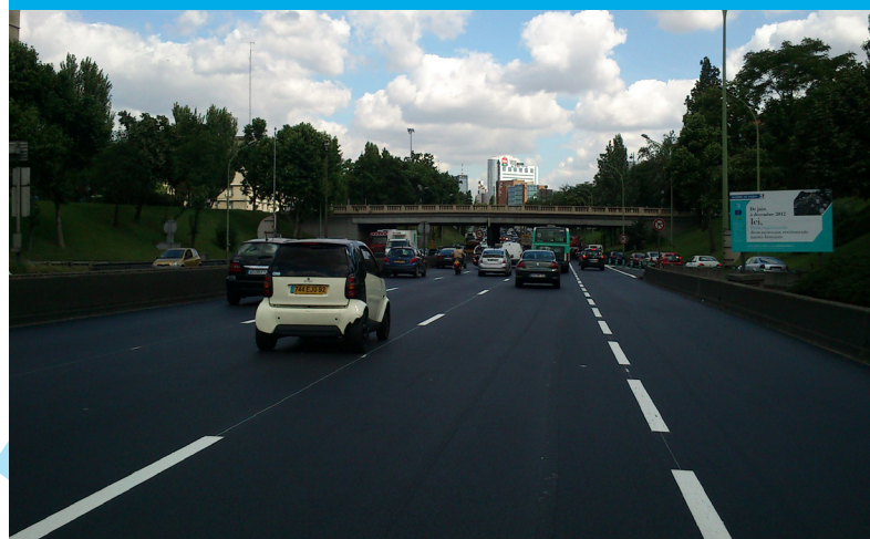
Expérimentation de revêtement acoustique sur le périphérique parisien au niveau de la porte de Vincennes.
